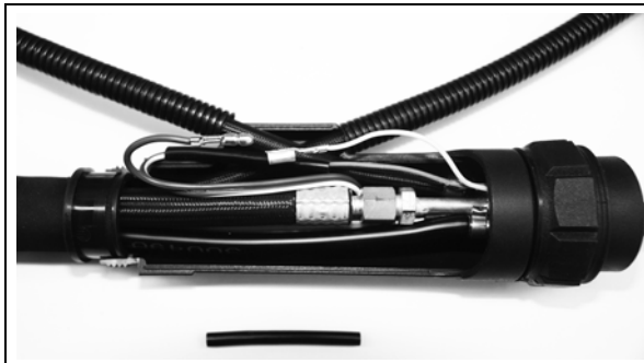
Abb. 16 Eine Tasterleitung demontieren
